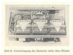
Unterbringung der Batterien unter dem Chassis DJ5MM
