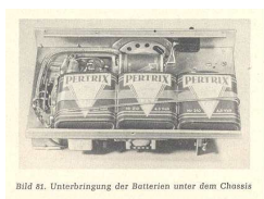
Unterbringung der Batterien unter dem Chassis DJ5MM
