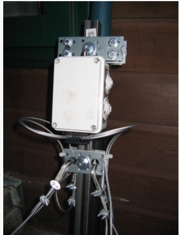
Transformator im geschlossenen Gehäuse
