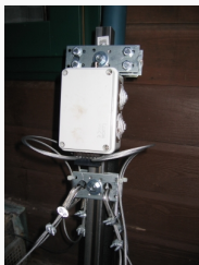
Transformator im geschlossenen Gehäuse
