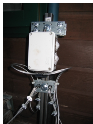
OE1IFM Transformator im geschlossenen Gehäuse
