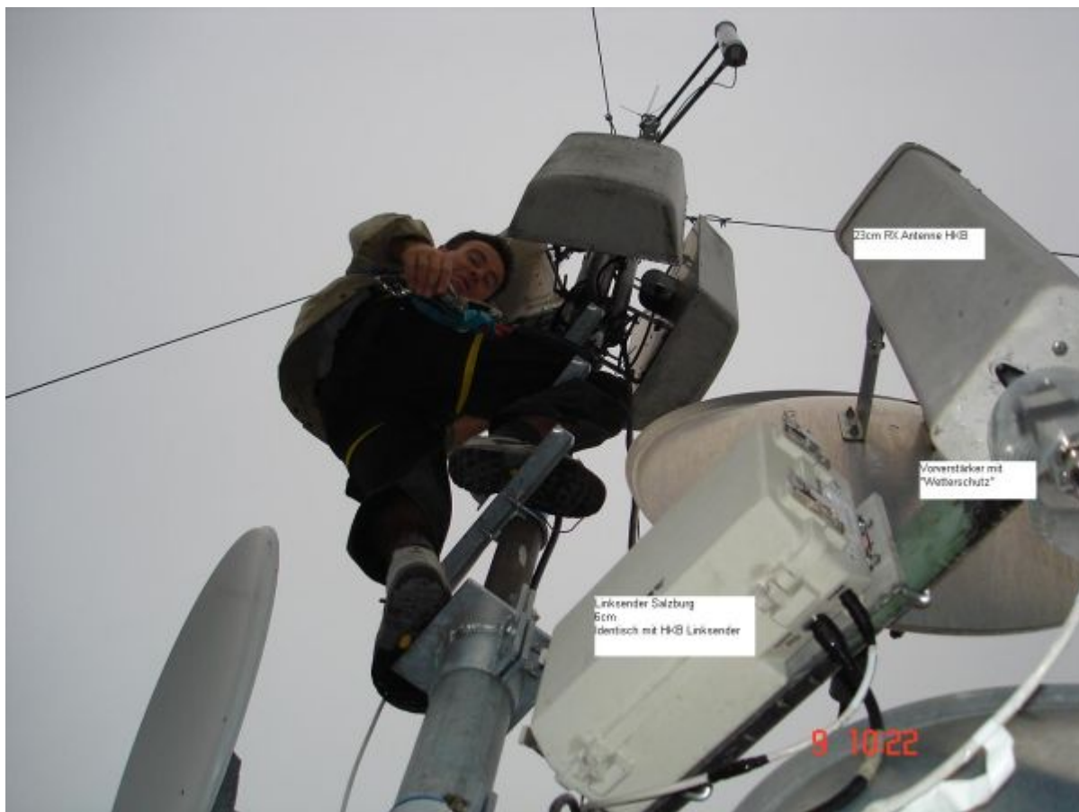
Arbeit am Mast 20m über Grund
