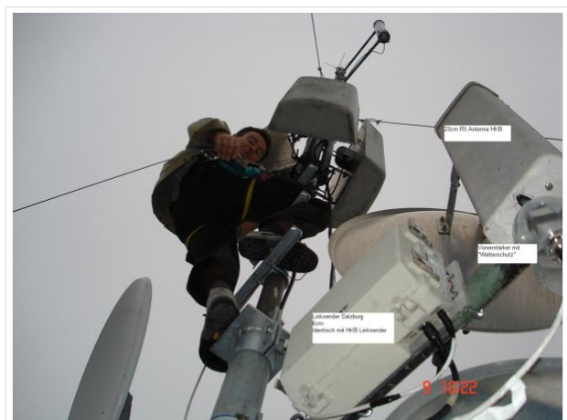
Arbeit am Mast 20m über Grund
