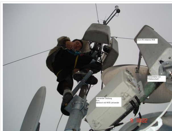
Arbeit am Mast 20m über Grund
