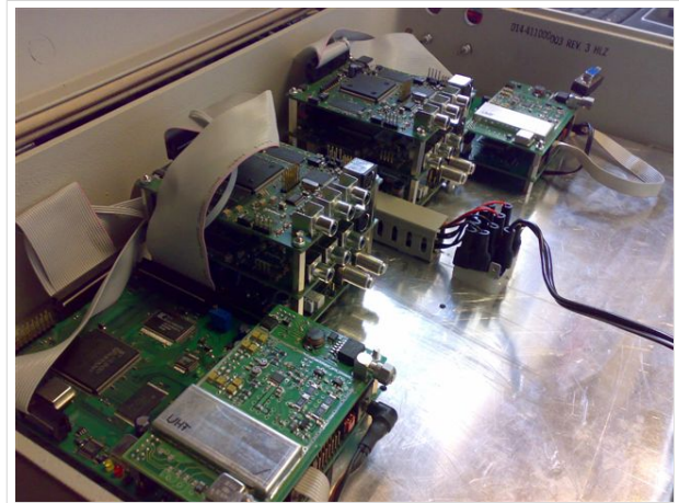
Der neu aufgebaute Digitale Linksender
